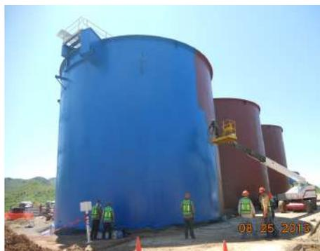
Proceso final de pintura en tanques de lixiviación.
