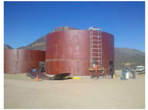
Tanque de lixiviación en proceso de fabricación en sitio.
