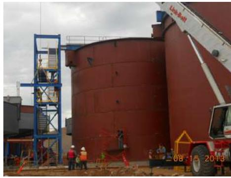
Tanque de lixiviación en proceso de pintura.
