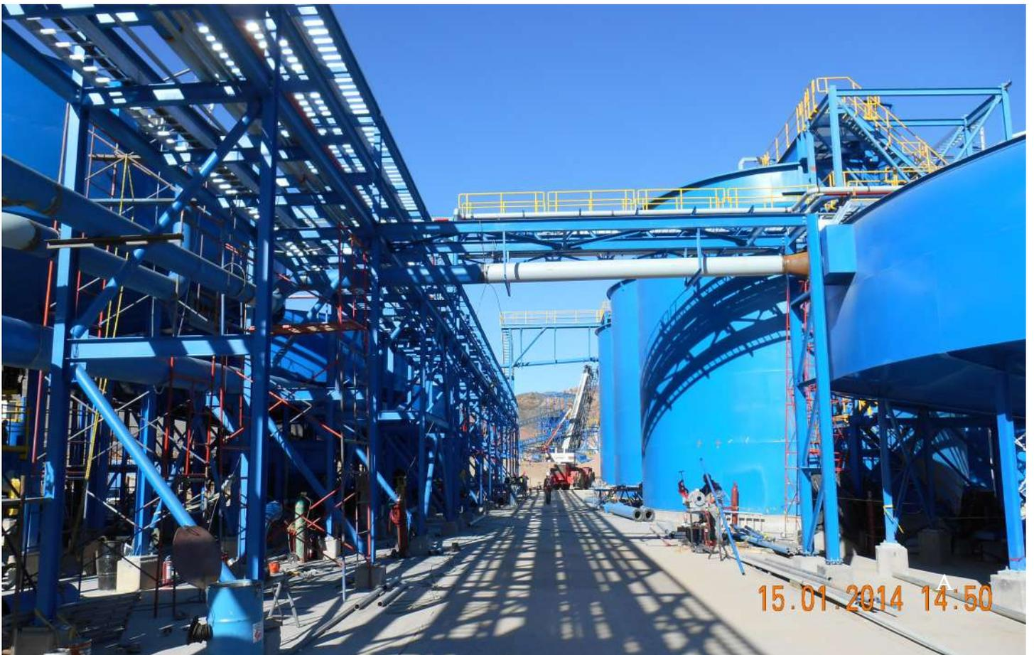
En este proyecto Grupo Cimasa suministro la ingeniería para la fabricación y el montaje de los transportadores de banda, chutes, estructura para edificios, rack de tuberías, tanques de lixiviación. Así como el montaje de todo el sistema de tuberías de acero al carbón, de acero inoxidable y de hdpe polietileno de alta densidad.
