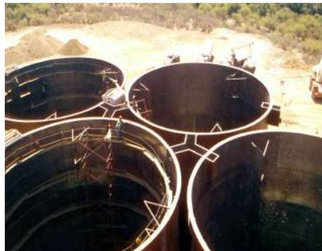
Tanques de Lixiviación en proceso de fabricación en sitio.
