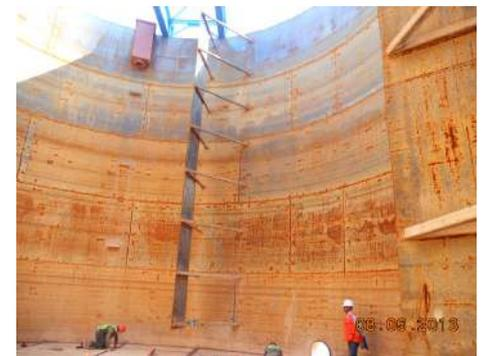
Tanque de lixiviación en prueba de líquidos penetrantes para liberación de soldadura en paredes de tanque.
