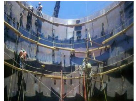
Interior de tanque de lixiviación en proceso de fabricación.
