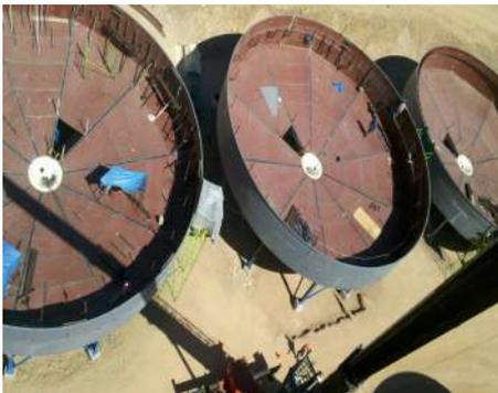
Tanques para espesadores de concentrado en proceso de fabricación en sitio.
