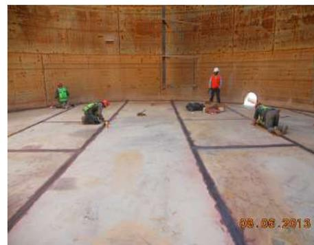
Tanque de lixiviación en prueba de líquidos penetrantes para liberación de soldadura en fondo de tanque.
