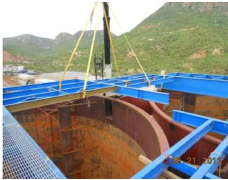
Montaje de estructura para acceso a parte superior de tanques de lixiviación.
